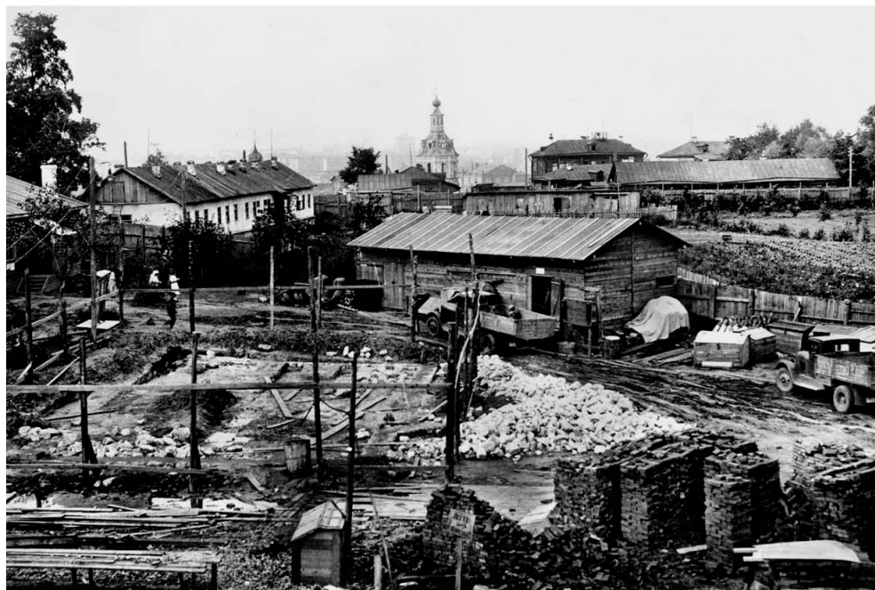
Строительство Института физических проблем
